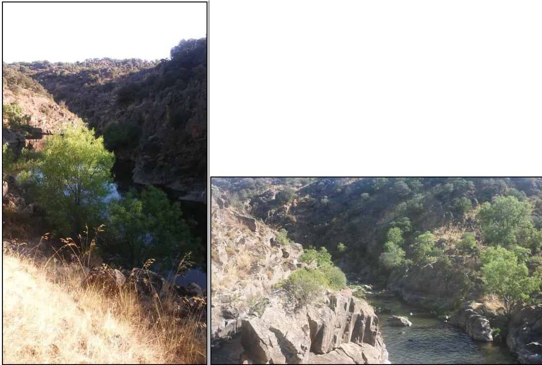
Figura 33: Distintas imágenes del recorrido Jerte 6, aguas abajo de la E.D.A.R. de Plasencia
