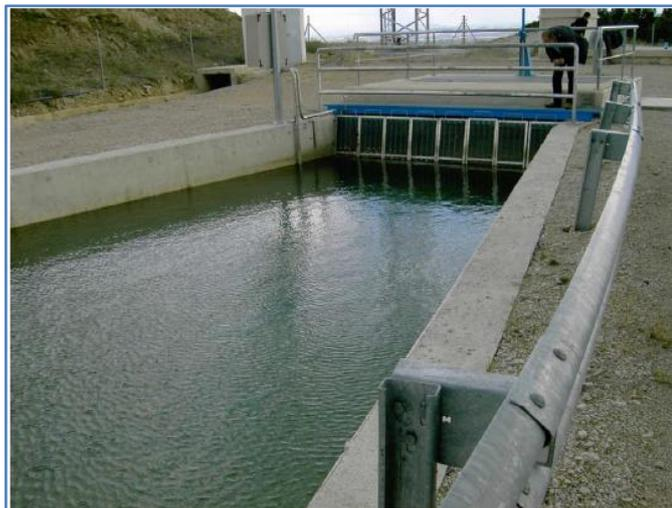
Ilustración 26. Filtro para final de canal. Fuente: Filtros Palacios, S.L.
